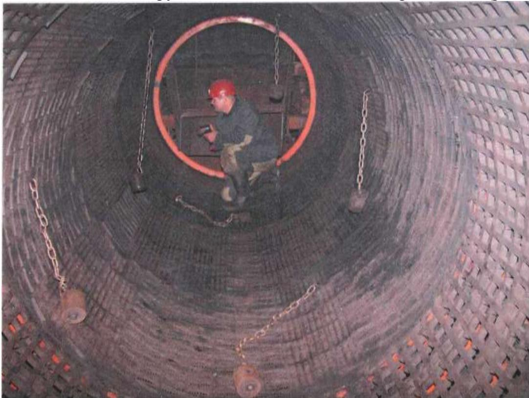
Рис. 5 - Система очистки рабочей поверхности ГБК подвесными ударными очистителями.
